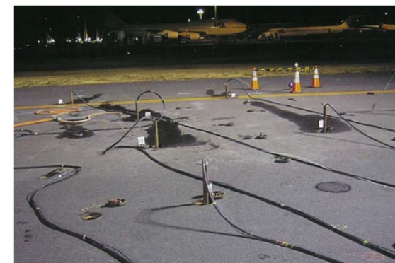
薬液注入状況（浸透固化処理工法）
