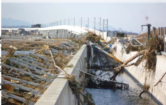
浸水、瓦礫散乱（アクセス鉄道北側）
